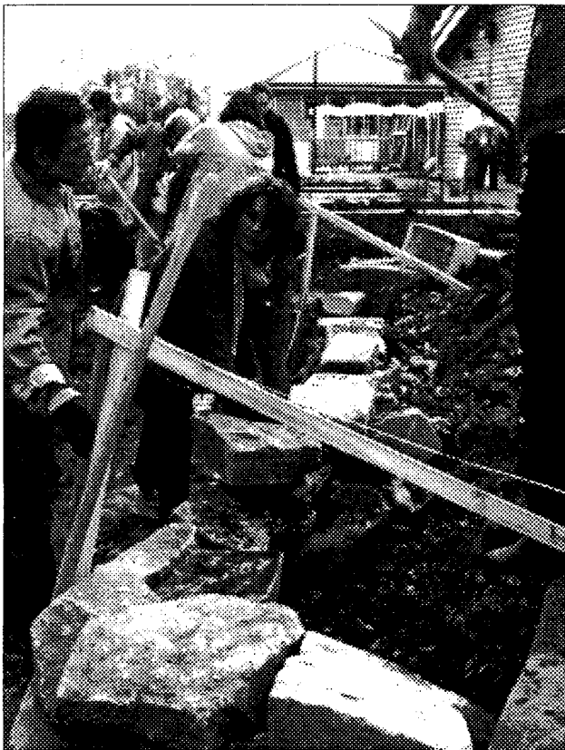
Aufschichtung von Natursteinen zu einer Stützmauer. Hinter den Steinen muss als „Drainage“ Lockergestein eingebracht werden. Wärmeliebende Tiere wie die Zauneidechse finden hier Unterschlupf.
